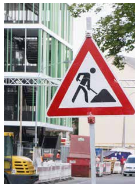
Das Baustellenschild bleibt länger stehen, eine Folge des Unwetters im Mai.
