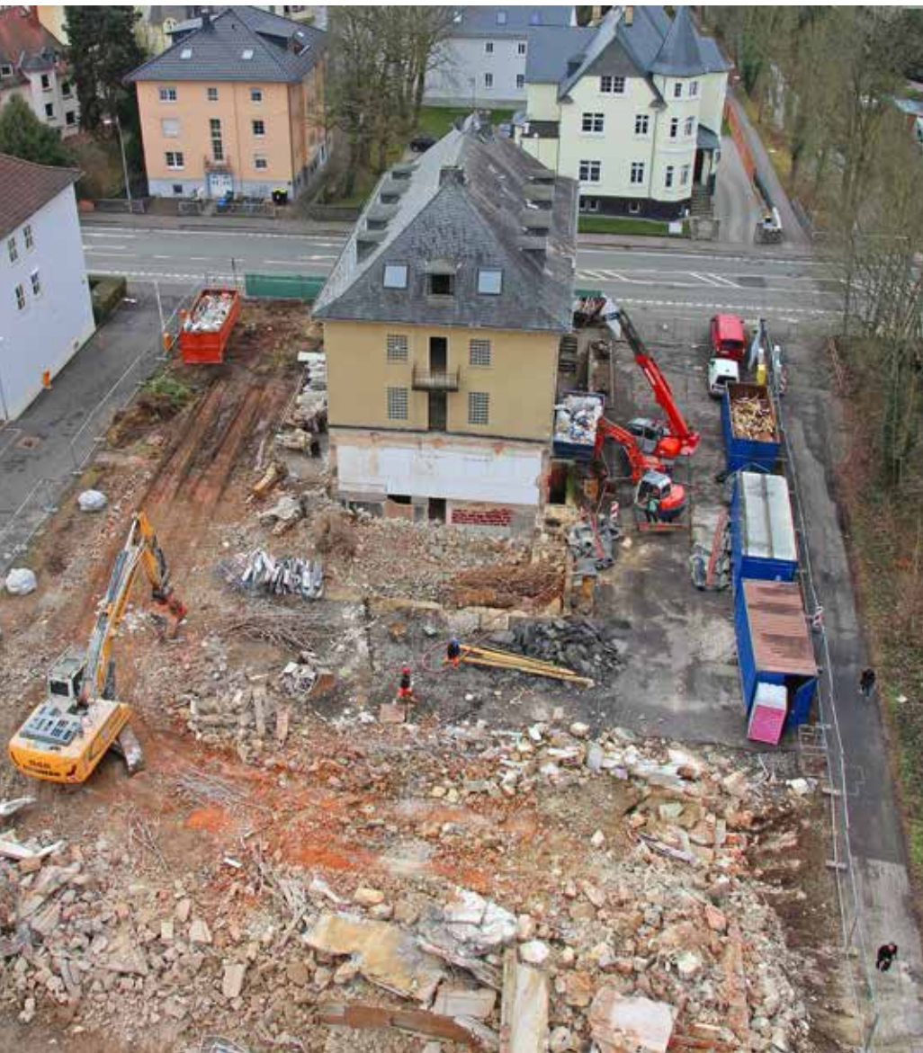
Dem Neubau ging die Beseitigung des Altbestandes voraus. Nach einer Zwischennutzung als Domizil des Kunstprojekts „kummerei“ wurde im Frühjahr auch das Haus an der Moltkestraße 11 abgerissen, um Bauland für die THM zu schaffen.
