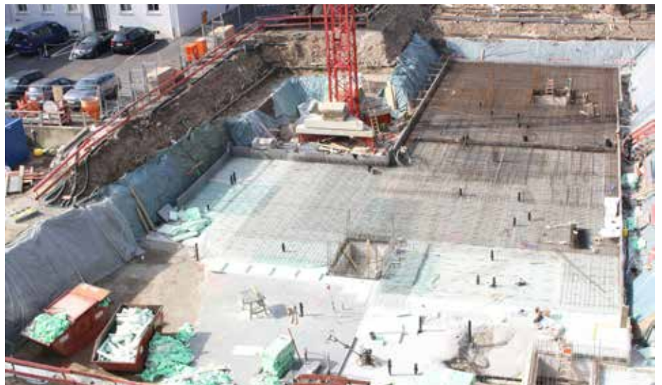
Kaum waren die letzten Reste entfernt, begannen die Arbeiten an der Bodenplatte des neuen Gebäudes für den Fachbereich Maschinenbau und Energietechnik.
