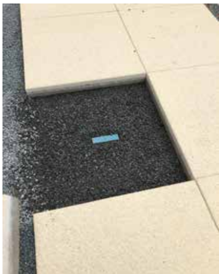
Ein RFID-Transponder wird vor dem Verlegen unter der Bodenplatte platziert.
