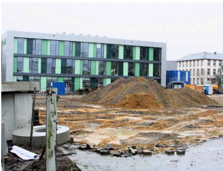
Der Baugrund zwischen Ringallee und Gutfleischstraße im Februar 2016.
