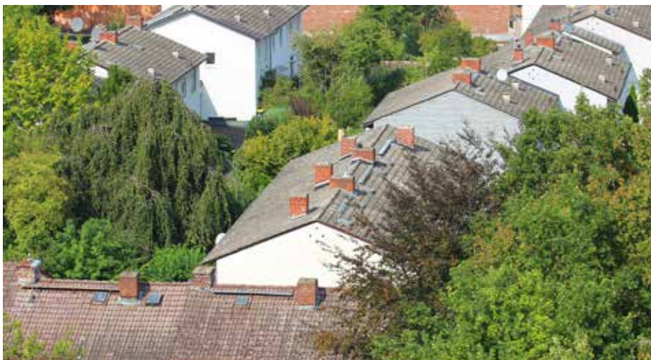
Die Projektpartner interessierte unter anderem, wieviel Platz für weitere Photovoltaik-Anlagen die Dachflächen im Versorgungsgebiet bieten.
