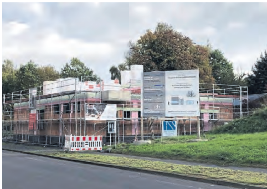
Neubau am Johannesberg: Lieferengpässe verzögern die Arbeiten am neuen Feuerwehrhaus.
