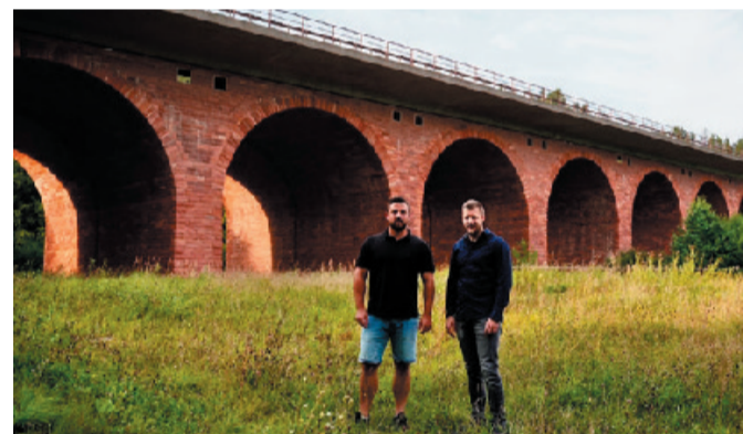
Beschäftigen sich mit der Asbachtalbrücke: Jonas Seitz (li) und Jan Saal.
