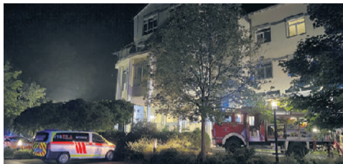
Ein Feuer entfachte sich im zweiten Obergeschoss der orthopädischen Klinik.
