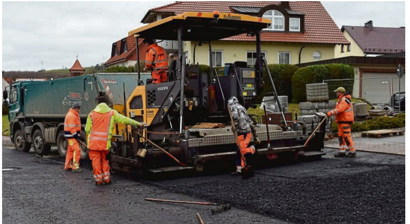
Arbeiter der Firma Räuber bauen die Asphalttragschicht in einer Zufahrt zur Ortsdurchfahrt in Eitra ein. FOTO: JANA GUTSCHEHN
