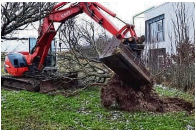
Schafft Platz für den Neubau: Auf dem Grundstück der geplanten Kinderkrippe in Friedewald laufen die ersten Arbeiten. Das einstöckige Gebäude entsteht neben der Kita „Schlosszwerge“.
