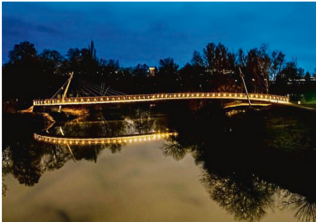
Beleuchtung im Handlauf: Dieses Bild der neuen s-förmigen einseitig aufgehängten Schrägseilbrücke in Bad Hersfeld gelang mit Langzeitbelichtung.
