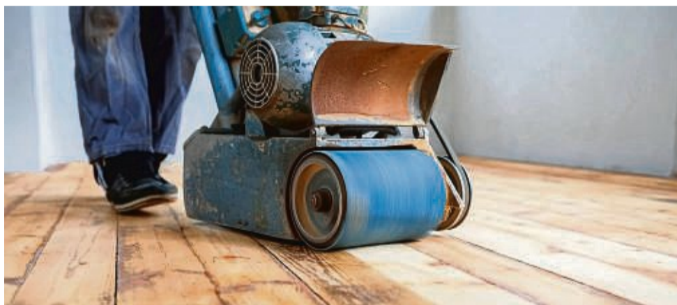
Mit Schleifmaschine den Parkettboden polieren und erhalten.
