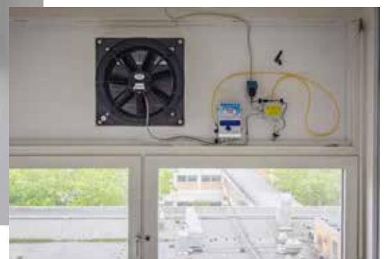
Ein Kipp-Fensteröffner und ein Ventilator bilden das Herzstück eines von THM-Forschern entwickelten automatischen Lüftungssystems für Seminar- und Klassenräume.
