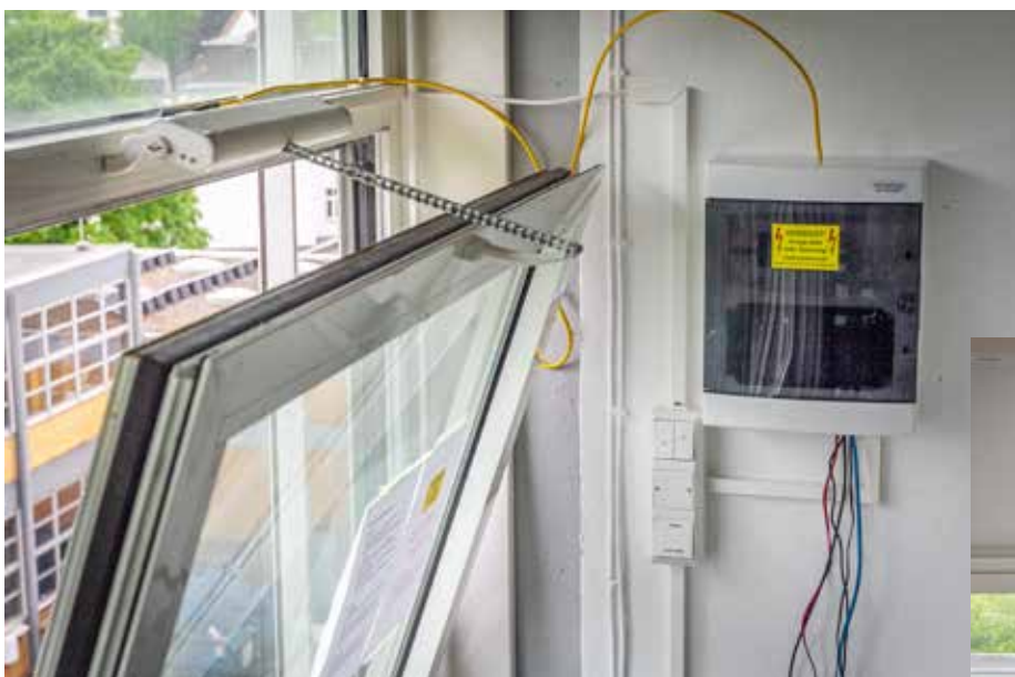
Ein Kipp-Fensteröffner und ein Ventilator bilden das Herzstück eines von THM-Forschern entwickelten automatischen Lüftungssystems für Seminar- und Klassenräume.
