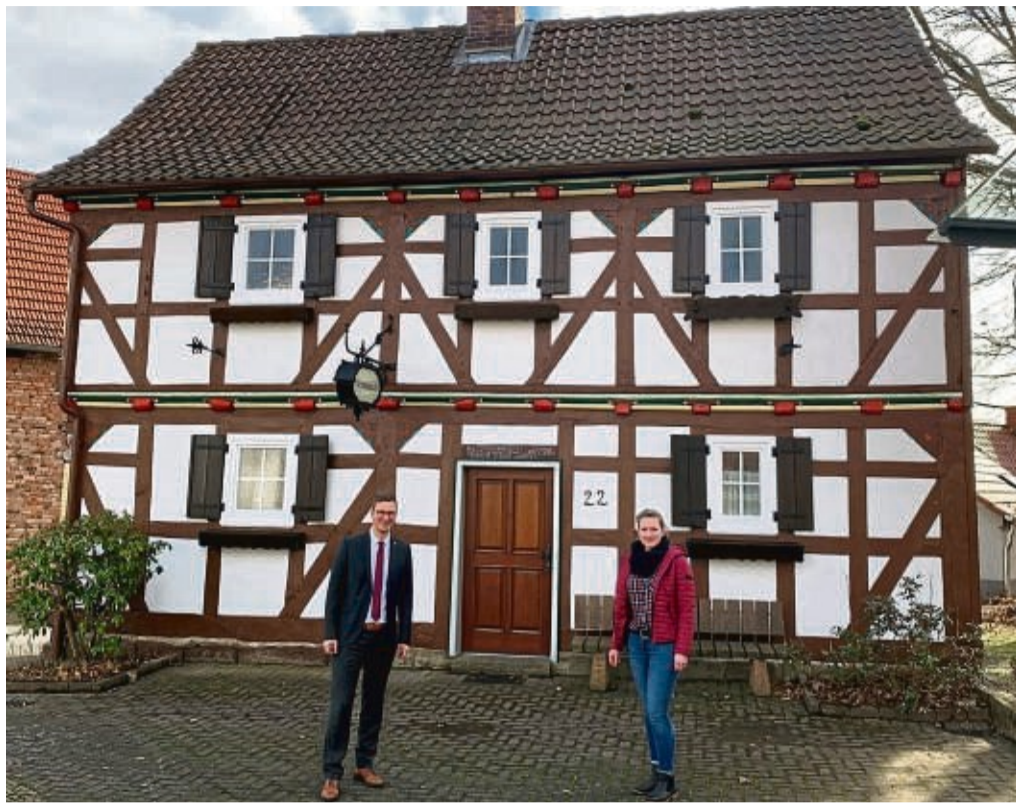
Schmuckstück: Hohenrodas Bürgermeister Andre Stenda und Ann Freund vom Fachdienst Ländlicher Raum des Landkreises Hersfeld-Rotenburg vor der sanierten Fassade des Heimatmuseums in Ransbach.
