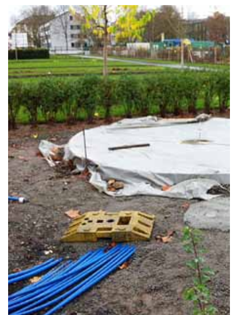
Im „Grünen Mathematikum“ sind die Rohbauarbeiten abgeschlossen.
