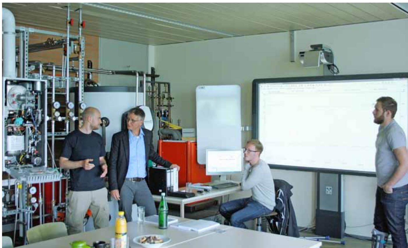
Bei der offiziellen Inbetriebnahme im THM-Labor stellten unter der Leitung von Prof. Dr. Boris Kruppa (2. von links) die Projekt Ingenieure Max Friedrich, Moritz Hofmann und Hendrik Dünfelder (von links) die KWK-Anlage vor.
