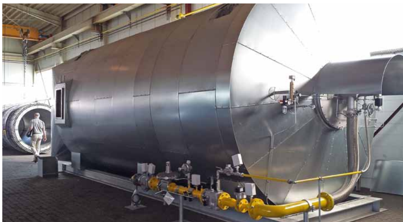
Anwendungsorientierte Forschung mit Nutzen für die Umwelt: Thermische Abluftreinigungsanlage als Energiequelle
