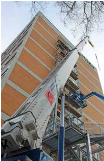
Bis 2018 wird die Instandsetzung des C-Gebäudes in der Gießener Wiesenstraße dauern.
