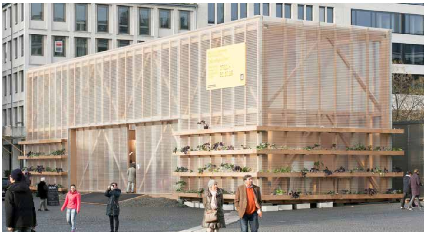
Der „Zukunftspavillon“ auf dem Frankfurter Goetheplatz ist 30 Meter lang, 10 Meter hoch und aus Buchenholz gezimmert. Vogelsberg war für die Tragwerksplanung verantwortlich.
