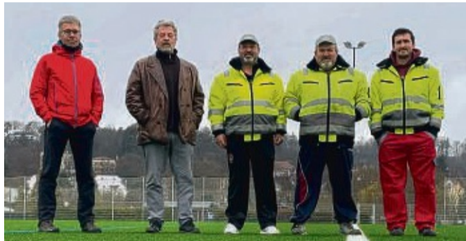
Die Winterpause ist vorbei: In nur wenigen Tagen hatten Paulo Salazar, Luis Mendonea und Antonio Pinheiro (von rechts) den Kunstrasen verlegt. Wie sich die Bauarbeiten genau gestalten, erklärten Martin Bode und Jobst Walter (von links).
