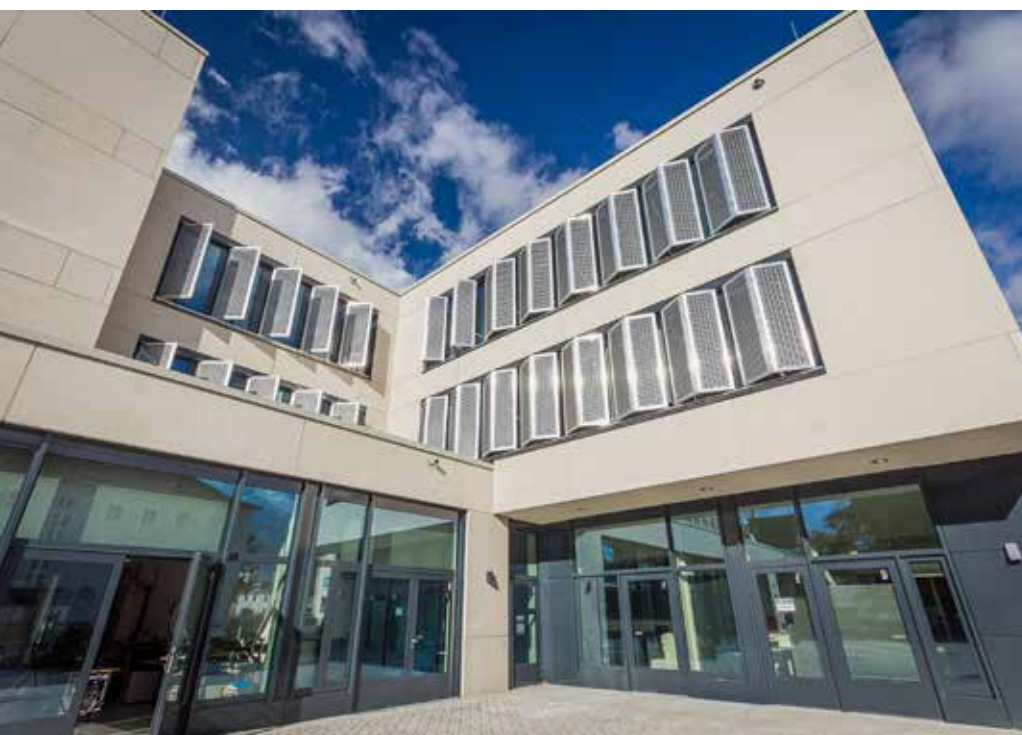
Das Gebäude C11 öffnet den neu entstandenen Campus-Bereich mit moderner Optik zur Moltkestraße hin.
