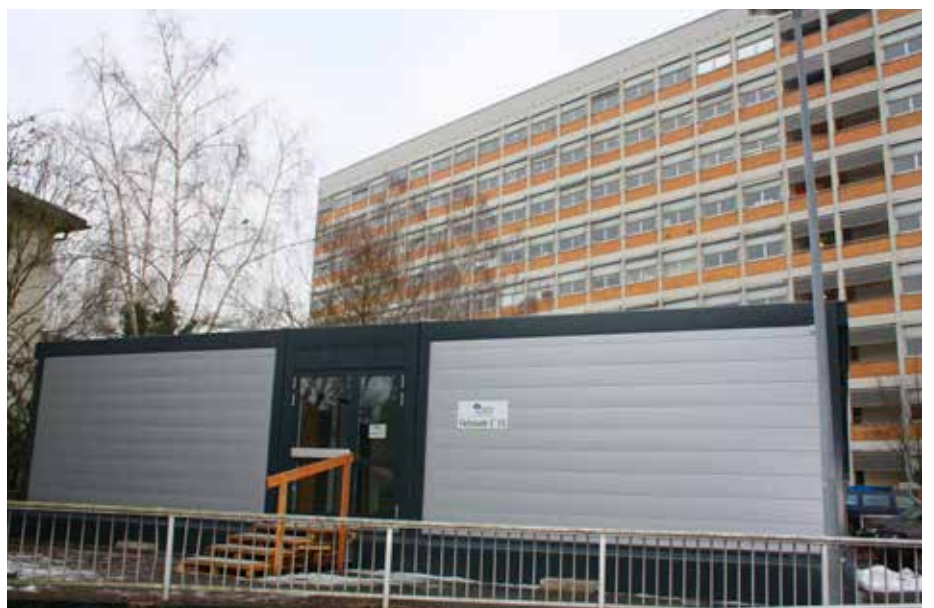
Auch eine Zwischenlösung: Zusätzlichen Raum für Lehre und Studium boten Container auf dem Parkdeck an der Ecke Eichgärten-/Ringallee.
