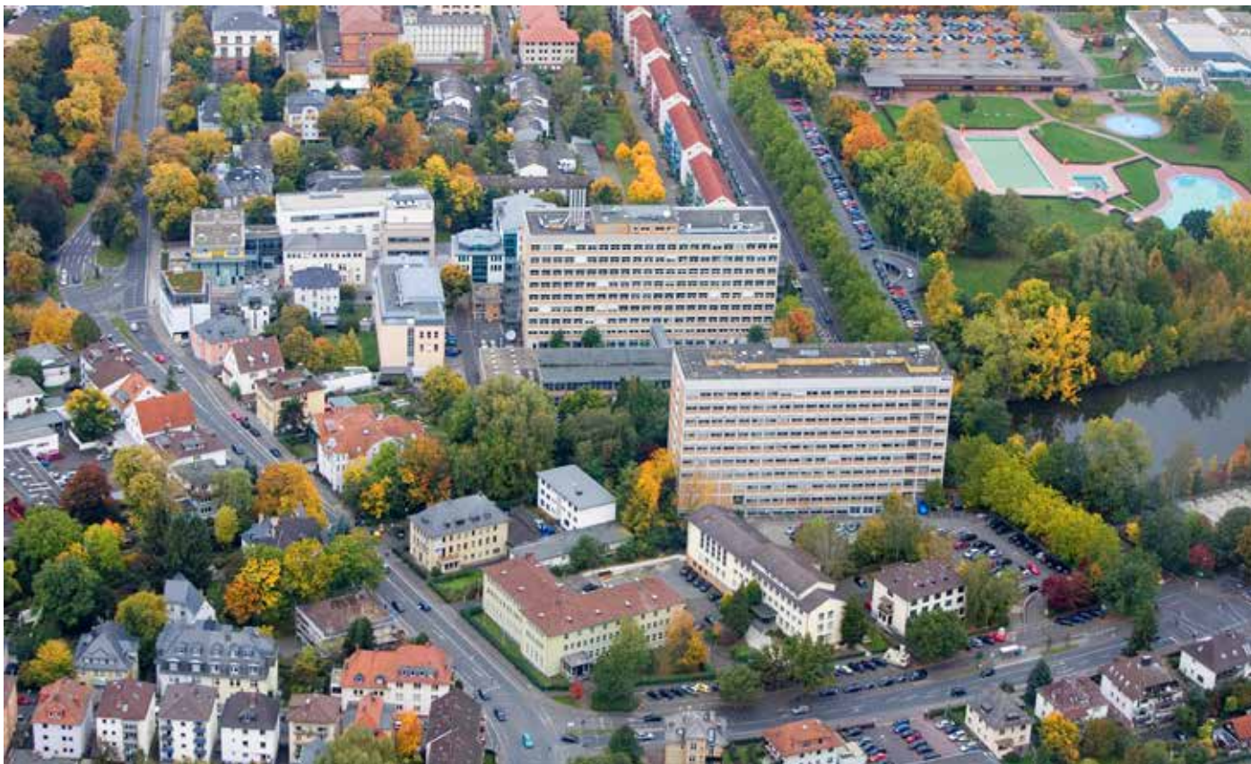
Die Luftaufnahme zeigt den baulichen Altbestand, bevor der C-Campus Wirklichkeit wurde: Links vom heutigen Gebäude C10 bis hin zur Moltkestraße das CVJM-Ensemble und an der Eichgärtenallee das damalige Haus der Industriegewerkschaft Bergbau mit dem benachbarten FH-Parkdeck gegenüber vom Schwanenteich.
