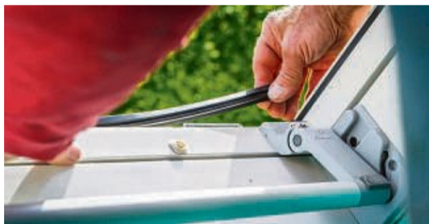
Schon der Tausch von Dichtungen kann helfen, Energiekosten zu sparen. FOTO: DJD/TLS-DACHFENSTER
