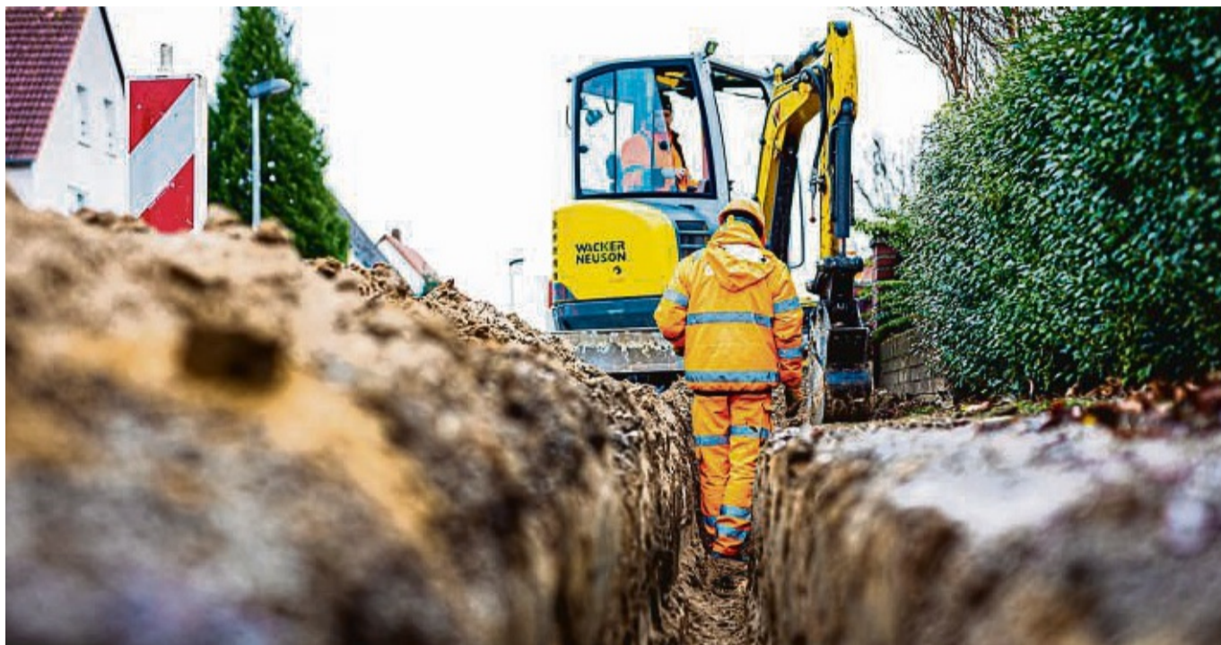
Bald sollen auch hier die Bagger rollen: Das Symbolbild zeigt die Glasfaserverlegung in Niedersachsen.
