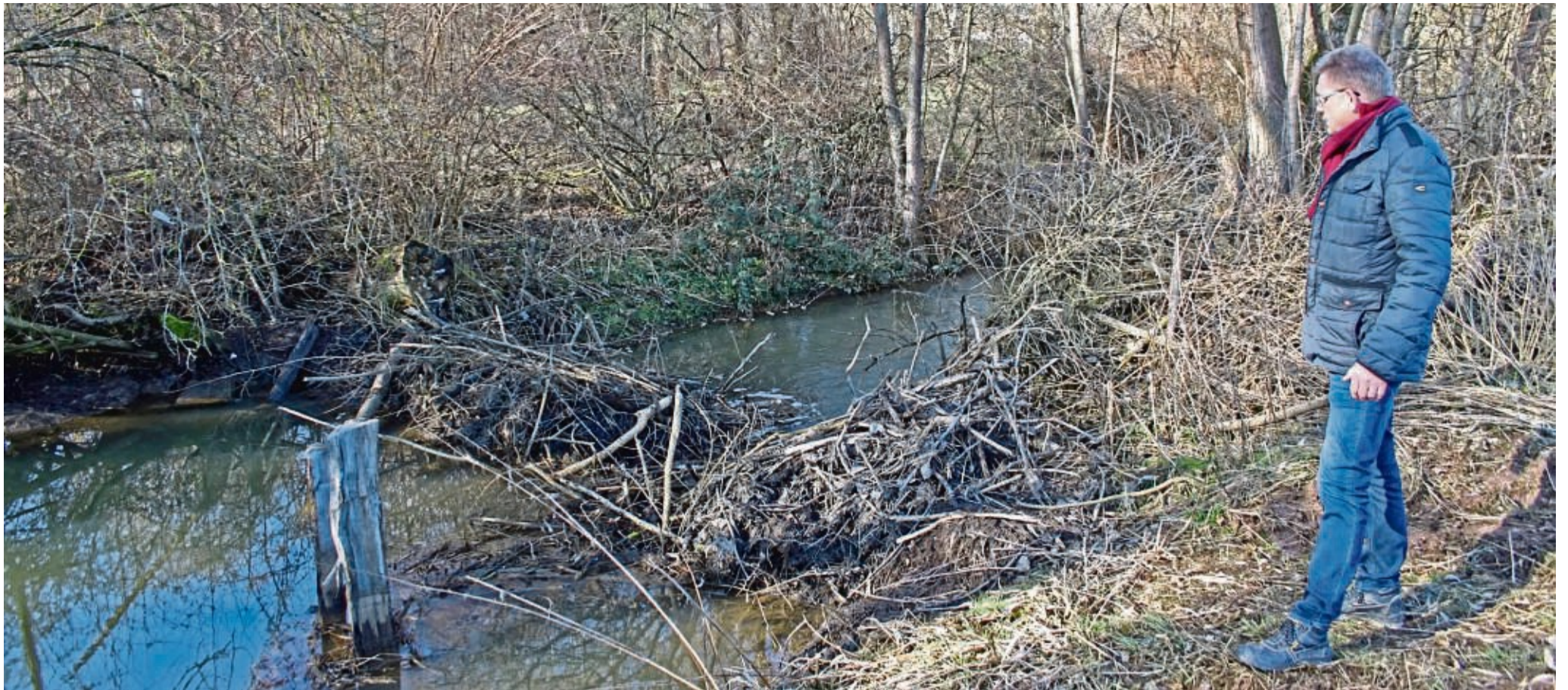
Einer der großen Biberbaue im Suhlbach in Wildeck-Obersuhl befindet sich auf halbem Weg zwischen dem Rhäden und dem Hallenbad. Bauamtsleiter Wilfried Kleinerüschkamp besichtigt den Bau. FOTOS (2): THOMAS KLEMM
