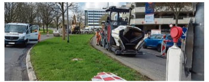
Vorbereitungen zur Vollsperrung: Bauarbeiter richten eine Überfahrt für Baufahrzeuge auf der Grünfläche zwischen den Fahrbahnen der Reichsstraße ein.
