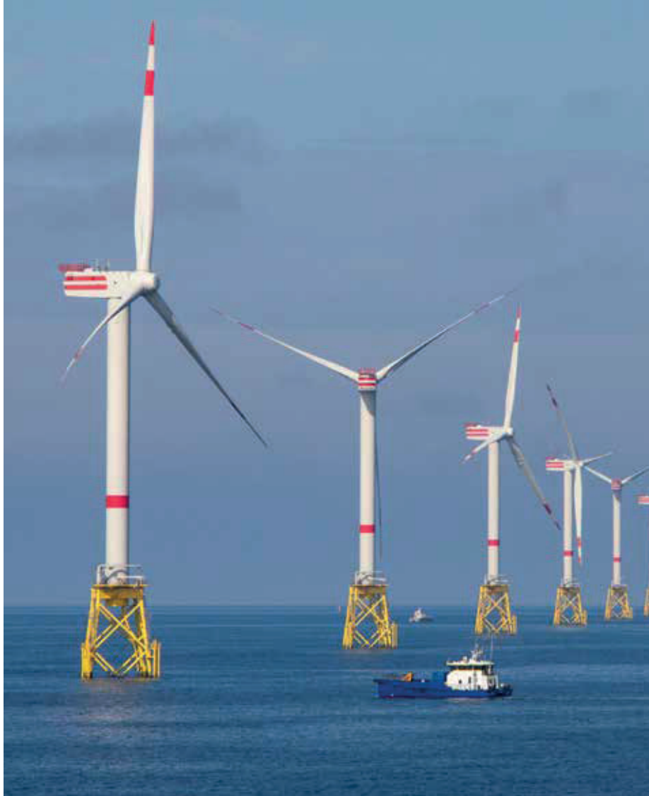
Windräder auf Jacket-Konstruktionen im Arbeitsprozess.
