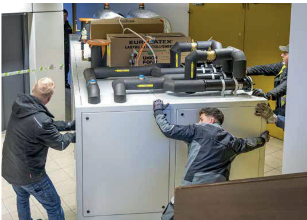
Techniker manövrieren die sperrigen Teile der Anlage im Dezember 2022 durch den Keller des Turms C10.
