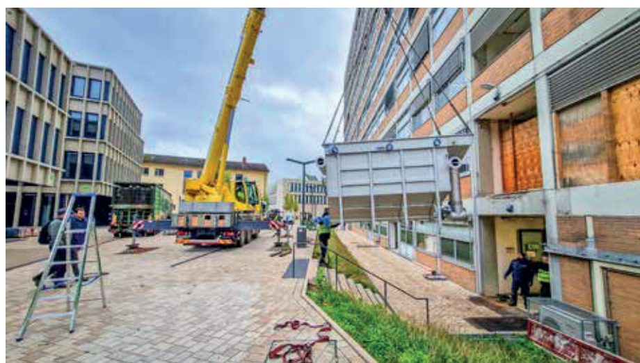
Die einzelnen Komponenten der Abwasserwärmenutzungsanlage müssen von einem Schwerlastkran von den Lastwagen gehoben werden.
