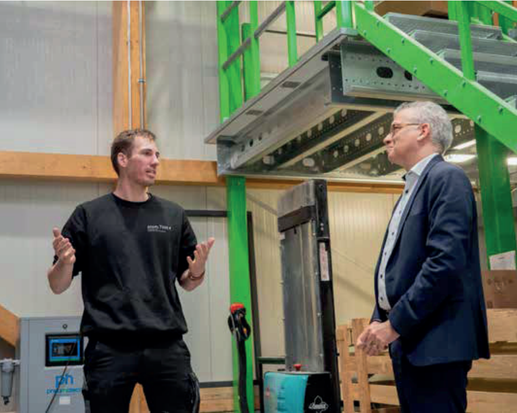
Falco Klaus (links) vom etem-Team erläuterte Minister Tarek Al-Wazir technische Details des Hybrid-speichers.
