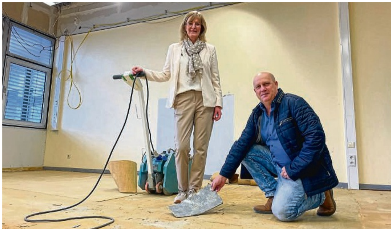
Hingeschaut: Anja Csenar und Klaus Kurz vom Fachbereich Schulen und Gebäude des Landkreises Hersfeld-Rotenburg schauen sich an der Gesamtschule Obersberg den Fortschritt der energetischen Sanierung in den Klassenräumen an.
