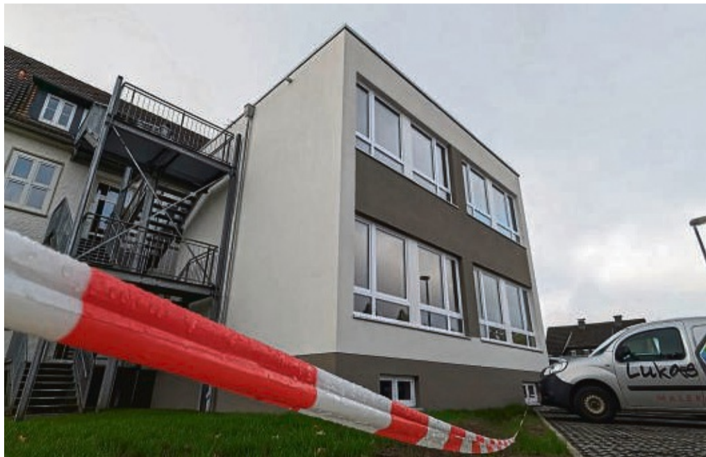
Das Flutterband hängt noch: Auch wenn das Absperrband noch im Wind flattert sind die Arbeiten beendet.
