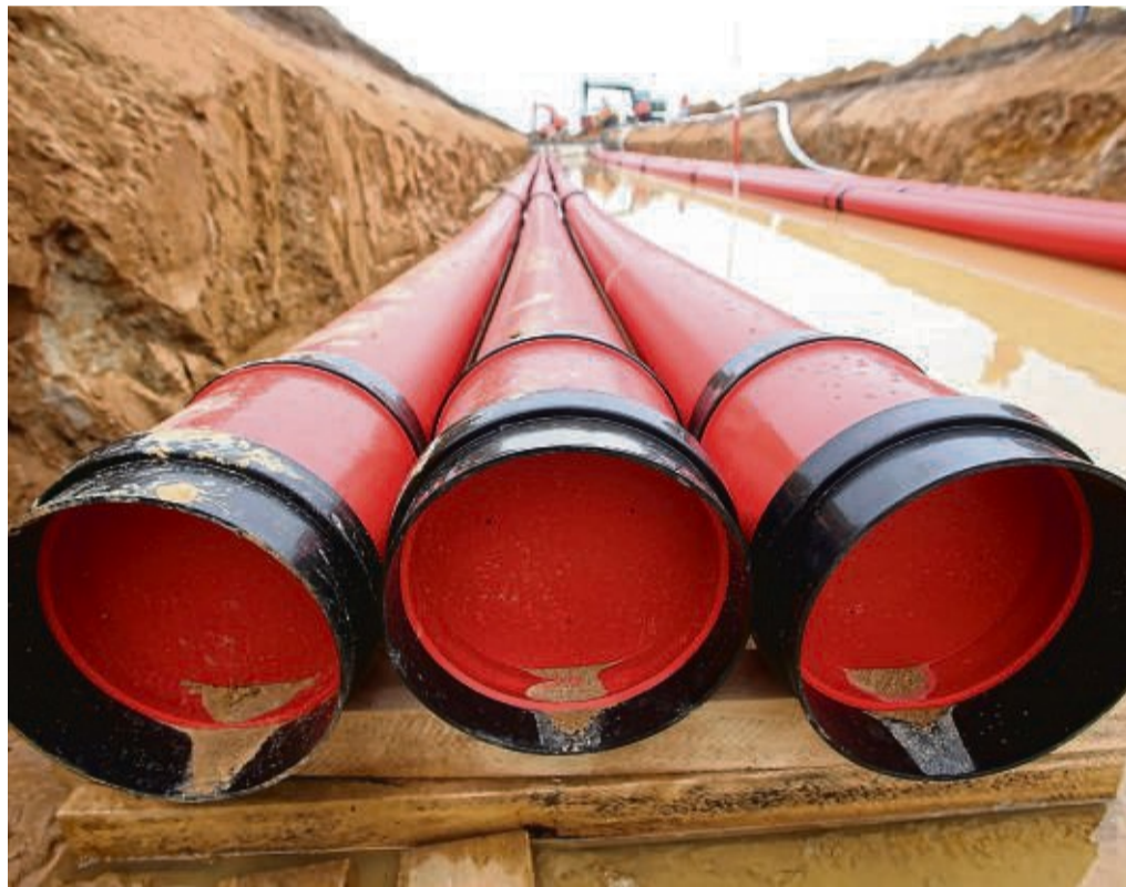
Die Mammut-Projekte „Nordwestlink“ und „Ostwestlink“ sollen in Nordhessen als zwei nebeneinander verlaufende Erdkabel verlegt werden - der Präferenzraum verläuft auch durch den Landkreis Hersfeld-Rotenburg.
