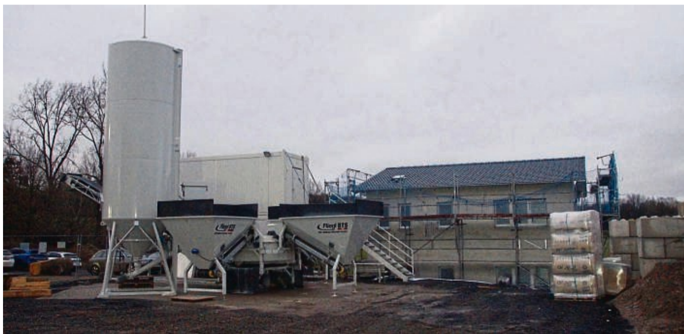
Beton auf Knopfdruk: Neben einer automatischen Mischanlage entsteht auf dem Gelände ein zweigeschossiges Gebäude mit Büroflächen zur Vermietung.
