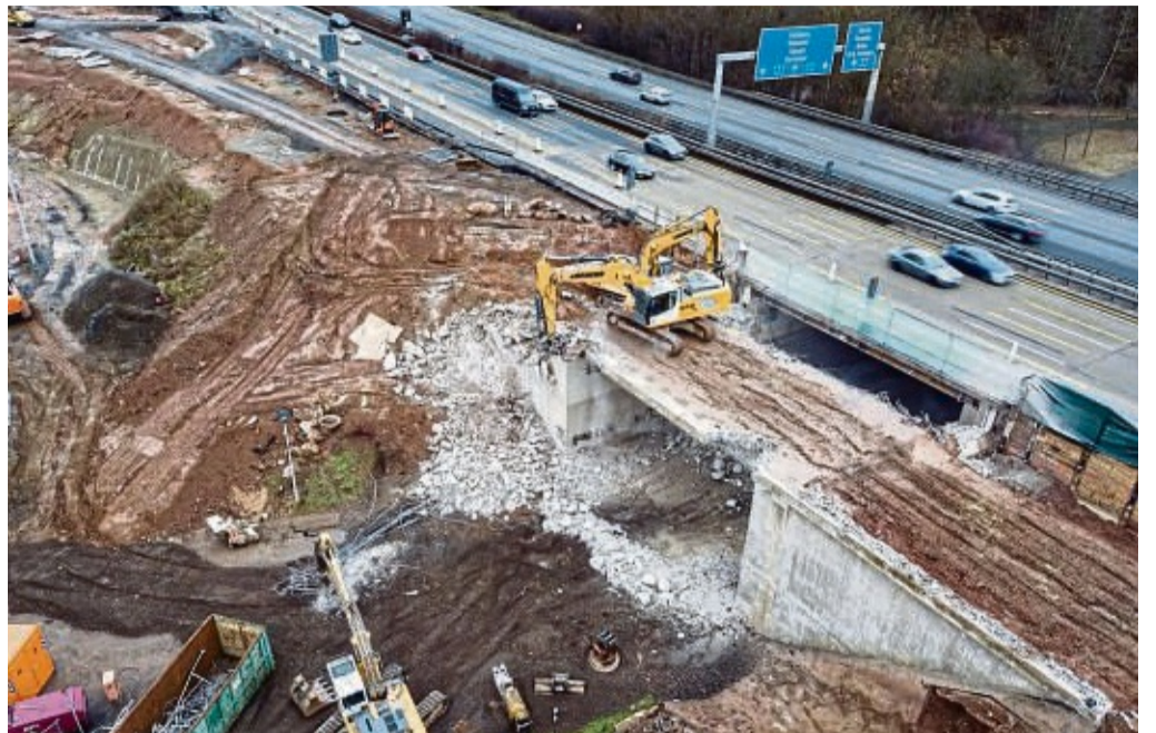
Engstelle: Grund für die Sperrungen am Kirchheimer Dreieck sind Abrissarbeiten am zweiten Teilbauwerk der Unterführung Schwimmbadstraße. Das erste Teilbauwerk – Bild – wurde bereits im Jahr 2022 abgerissen und neu gebaut.
