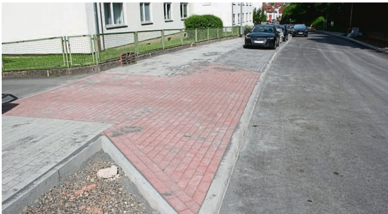
So schaut's aus: Wie ansprechend sich zukünftig die Gehwegflächen, die Grundstückszufahrten und die Parkstände an der Meisebacher Straße in Bad Hersfeld darstellen werden, ist bereits im unteren Bereich erkennbar, wo der erste Bauabschnitt bereits seit dem 19. Februar im Gange ist.
