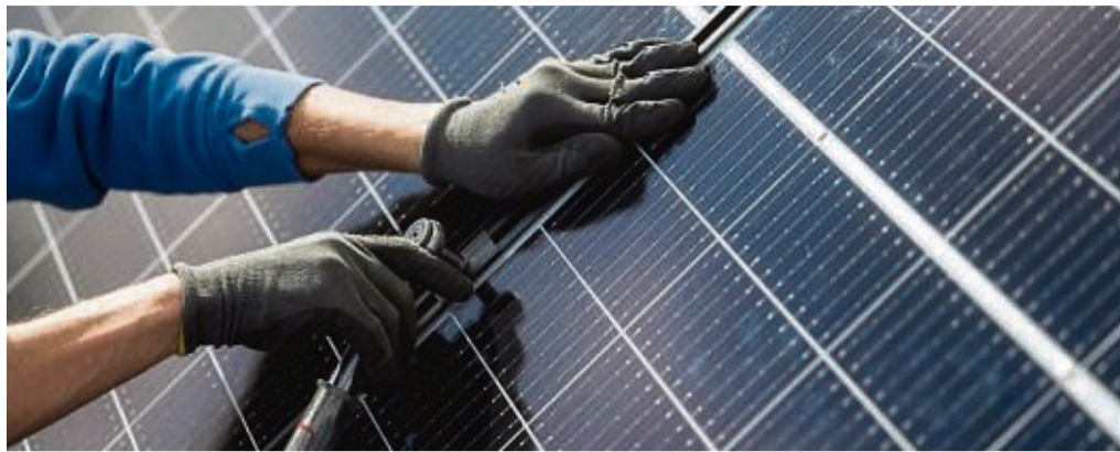
Eine durch Stürme zerstörte Photovoltaikanlage in Malsfeld hat die Energiegenossenschaft Hersfeld-Rotenburg jetzt wieder aufgebaut.
