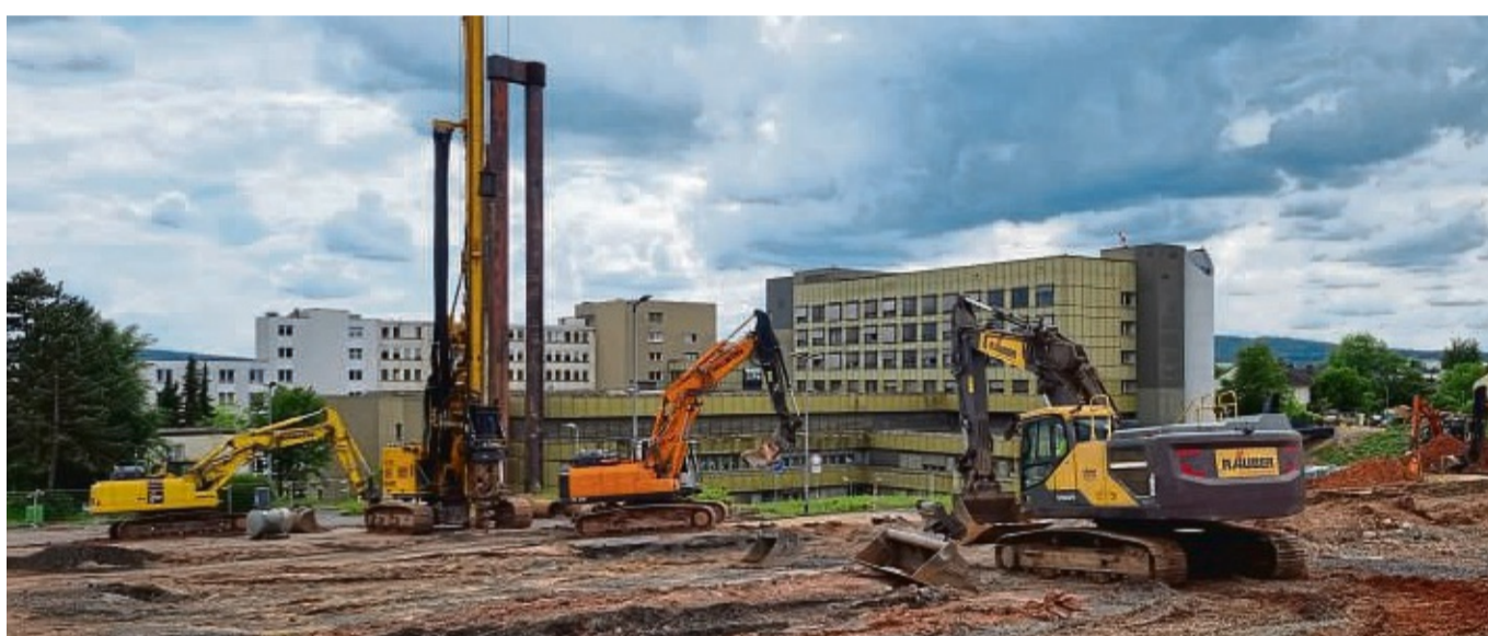
Am Klinikum in Bad Hersfeld rollen die Bagger: Während der Kreistag über eine neuerliche Finanzspritze gerungen hat, gingen die Bauarbeiten für den Neubau mit Volldampf weiter. FOTO: KAI
