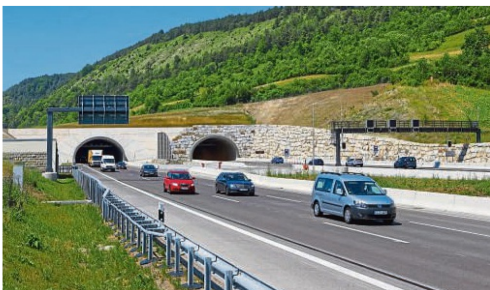
Die über 270 Tunnel auf deutschen Autobahnen und Bundesstraßen gehören zu den sichersten der Welt. Das richtige Verhalten ist dennoch wichtig. FOTOS: DJD/SCHOLZ & FRIENDS
