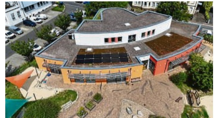
Strom vom Dach: Die Kita „Abenteuerland“ verfügt nun über eine Photovoltaikanlage. Gespendet und installiert hat sie die Firma Elektro Hess.
