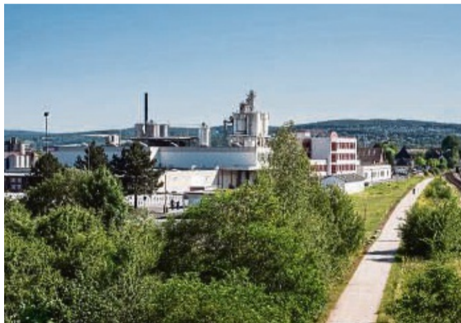
Die Firma Börner zwischen Landecker Straße und Bahngleisen blickt auf eine 140-jährige Geschichte als Chemisches Werk für Dach- und Bautenschutz zurück. FOTO: SCHUPMANN/ARCHIV
