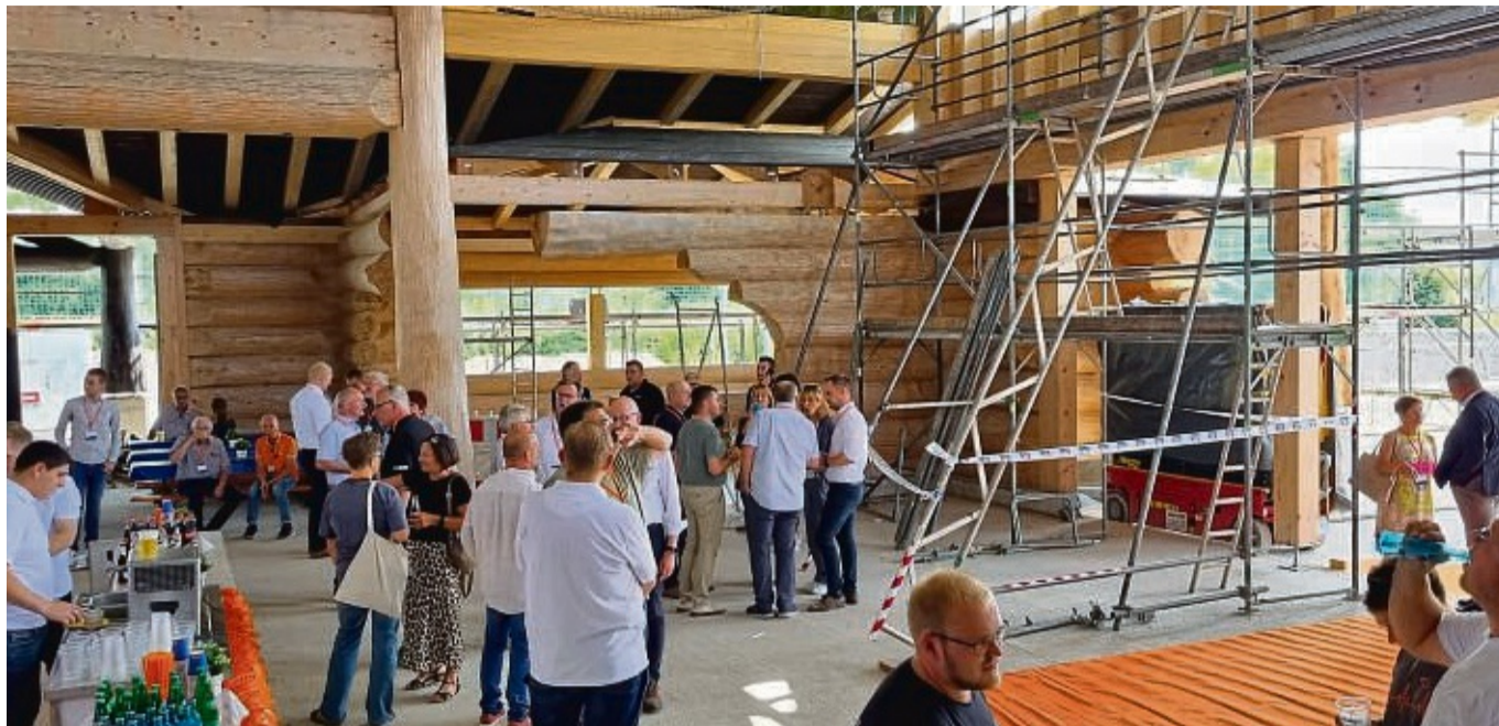
So sieht es im Inneren des Holzhauses aus: Nachdem die Stämme für das neue Timberjacks-Restaurant schon vorgefertigt und probemontiert worden waren, ging der Aufbau recht schnell. Jetzt geht es an den Innenausbau. FOTOS KAI
