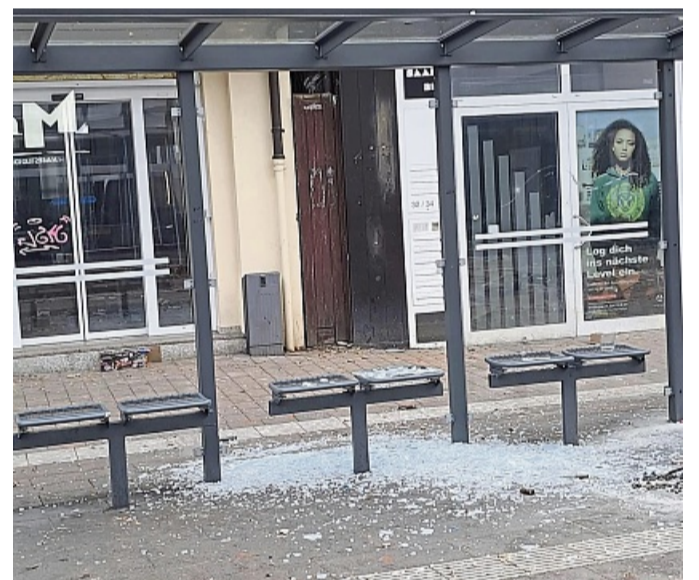
Zerstört: Auch die Buswartehalle in der Breitenstraße wurde durch Böller schwer beschädigt.
