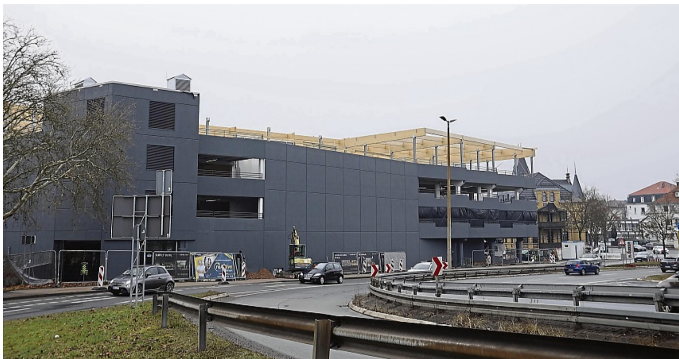
Das VR-Bank-Quartier in Bad Hersfeld nimmt langsam neue Formen an. Der Holzaufbau auf dem Dach ist Basis für die Photovoltaik-Anlage. FOTO: CHRISTOPHER GÖBEL
