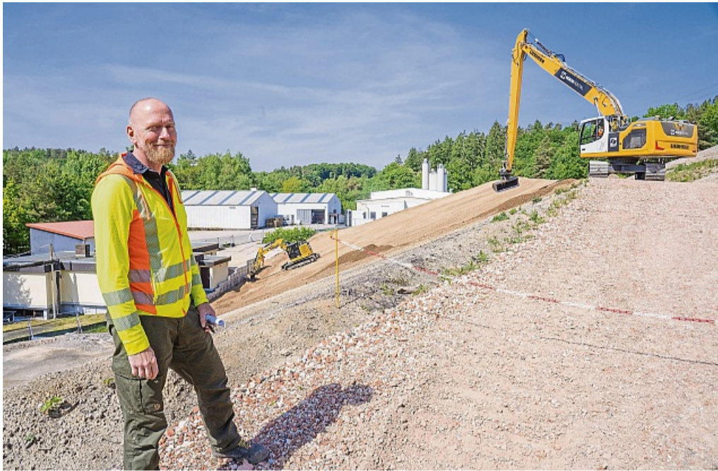
Für den Feinschliff sorgen Bagger, die die Oberfläche der Halde glattziehen und für die Folie vorbereiten. Michael Sieber verschafft sich von oben einen Überblick. FOTOS: KIM HORNICKEL
