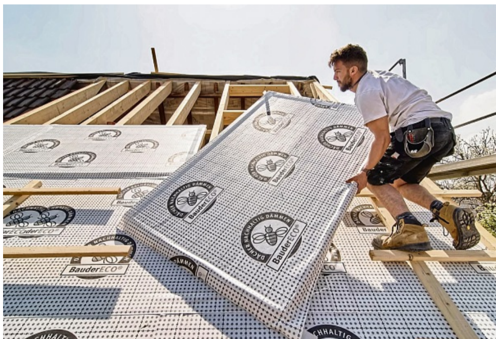
Eine nachträgliche Dämmung des Dachs trägt in älteren Gebäuden wesentlich zu mehr Energieeffizienz bei. FOTO: DJD/PAUL BAUDER/WWW.MICHAELGALLNER.COM
