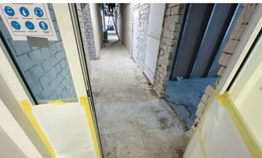
Abriss- und Neubauarbeiten im InfraServ Wiesbaden Bildungszentrum.
