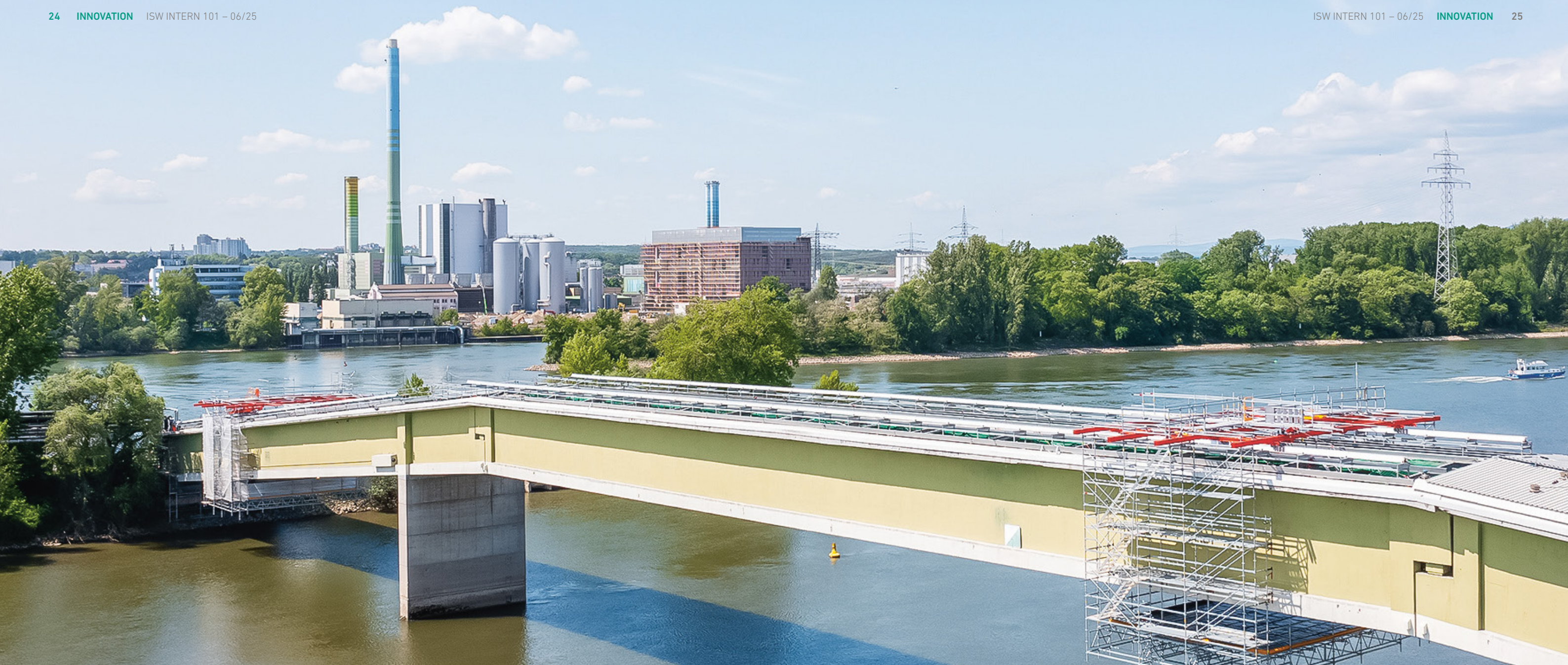
Für die Baumaßnahmen wurde ein befahrbares Hängegerüst angebracht, das über die Längsachse der Brücke bewegt werden kann. Mit seiner Hilfe lassen sich die Außenflächen bearbeiten. Foto: PERI Deutschland
