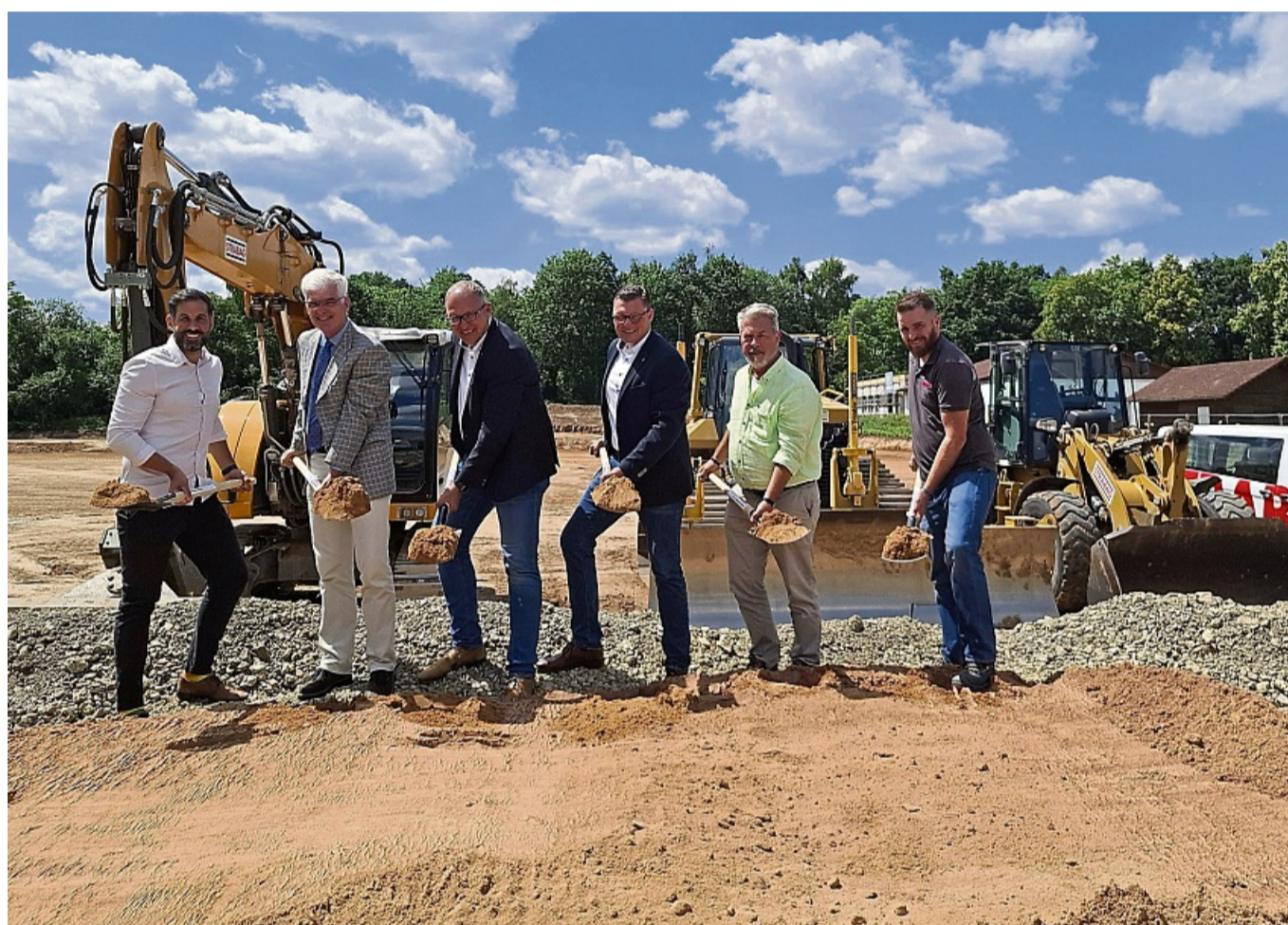
Erster Spatenstich: Daniel Iliev (Sportkreis), Landrat Torsten Warnecke, Bürgermeister Thomas Rohrbach, Wilhelm Gebhard (Bundestag), Jobst Walter (Ingenieur) und Sebastian Deppe (Strabag). FOTO: DAG
