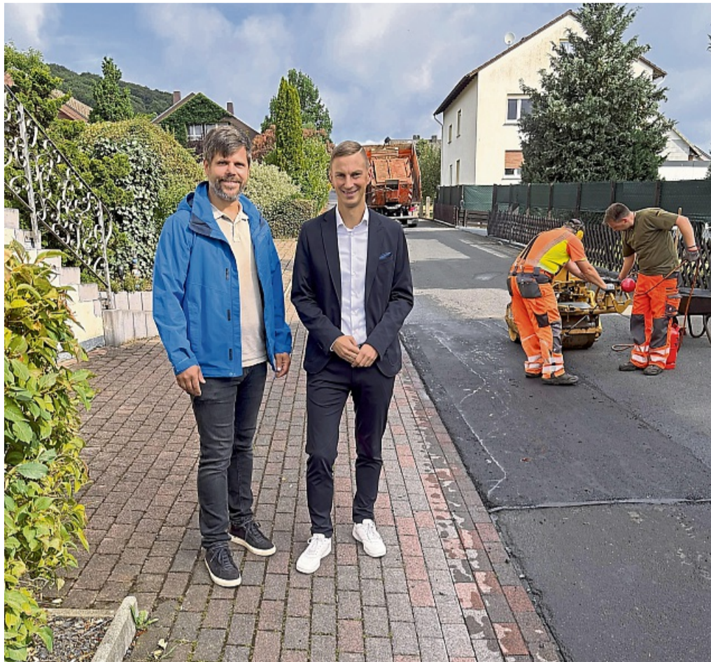
Besuch auf der Baustelle: (links) Bauamtsleiter Patrick Pingitzer und Bürgermeister Andre Stenda sowie die Bauhofmitarbeiter Rene Wolf und Markus Lehn bei den Straßenerhaltungsmaßnahmen im Ortsteil Ausbach.
