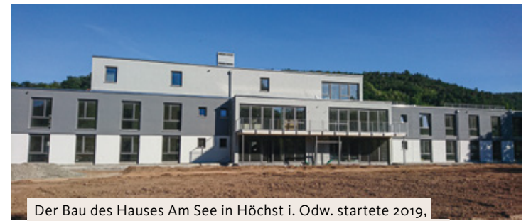
Der Bau des Hauses Am See in Höchst i. Odw. startete 2019, im Juli 2020 wurde es eröffnet. Das Foto entstand im Mai 2020.
