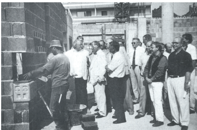
1995: Grundsteinlegung für das neue Martinsstift in Mainz
