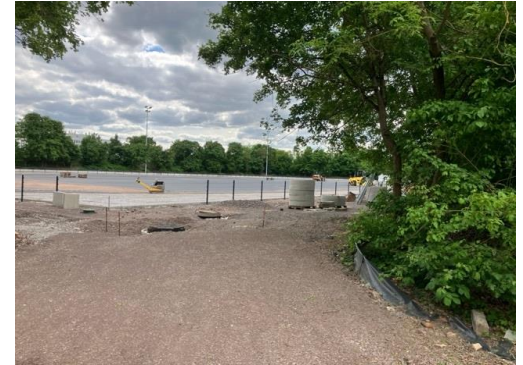
Baumaßnahme auf der Sportanlage Am Römerhof © Sveja Gondolf
