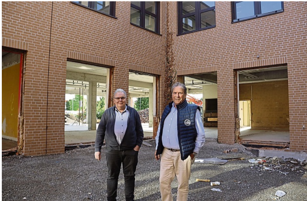
Edeka-Markt-Inhaber Thorsten Hellwig (rechts) und Ehrenfried Schorn von der Geschäftsleitung auf der Baustelle im Rechberggelände. FOTOS: CHRISTOPHER GÖBEL
