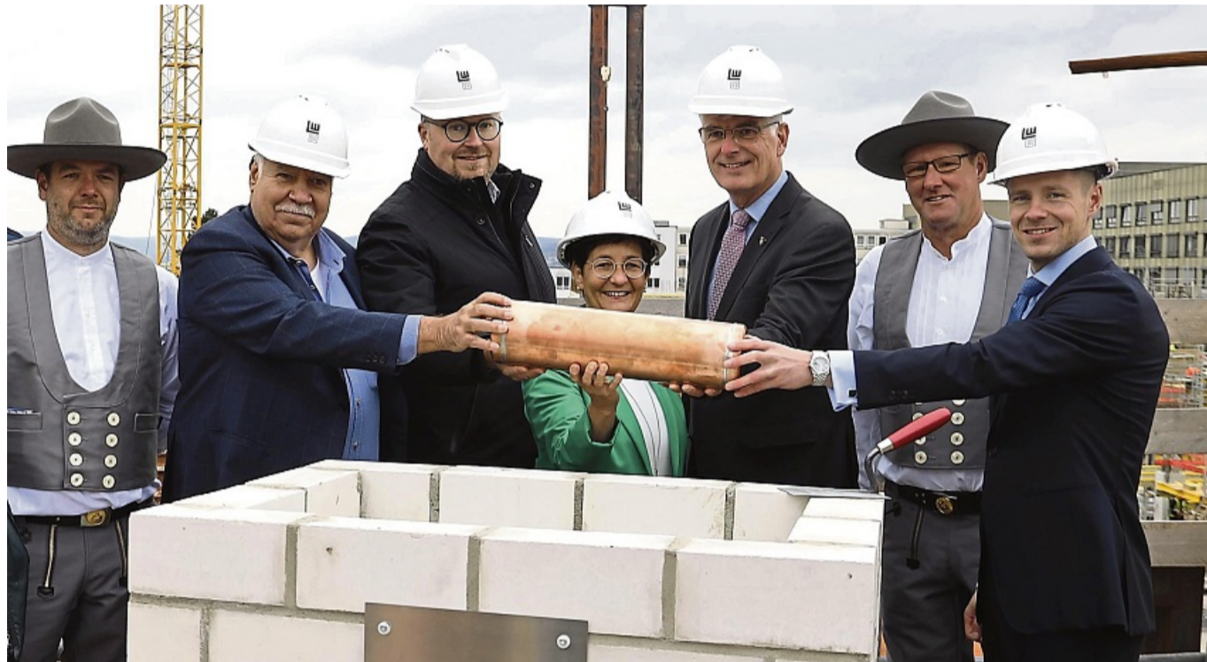
Grundsteinlegung zum Neubau des Klinikums Bad Hersfeld: Das Foto zeigt Vertreter des Klinikums, der Baufirma Leonhard Weiss und der Kommunalpolitik beim Bestücken des Grundsteins. FOTO: CDG
