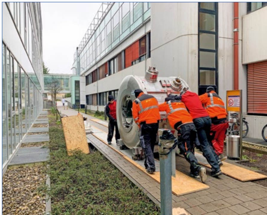
Im Herbst wurde das 6,5 Tonnen schwere Gerät angeliefert und eingebaut.
