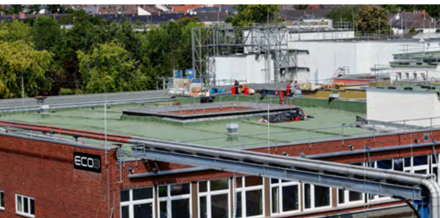
Abgeschlossene Dachsanierung des ECO3-Betriebgebäudes.
