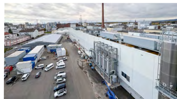
Der Neubau für die Polyesterfolienproduktion von Mitsubishi Polyester Film (rechts) mit davor errichteter Lagerhalle.
