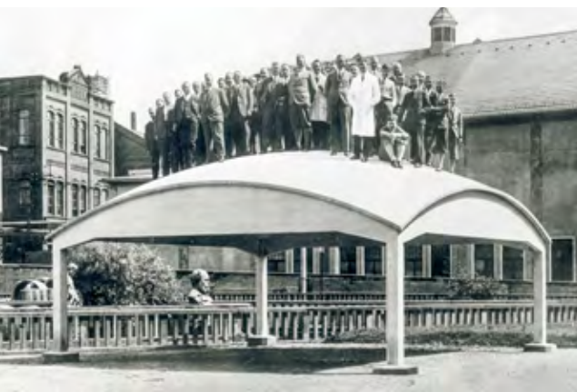
Ein Foto, das Baugeschichte schrieb: 50 Mitarbeitende der Firma Dyckerhoff & Widmann AG (Dywidag) stehen am 17. August 1931 in Wiesbaden-Biebrich auf der Schalenkonstruktion und bestätigen damit deren Belastbarkeit. Foto: Dyckerhoff
