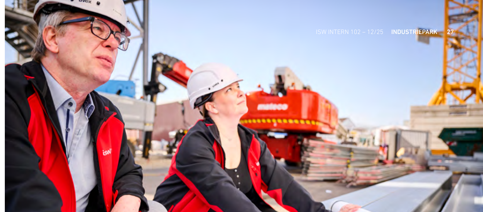
Janine Pasel und Peter Blaschke, Planungsingenieure Hochbau bei der ISW Technik, auf der Baustelle für die neue Folienproduktionsanlage von Mitsubishi Polyester Film.
