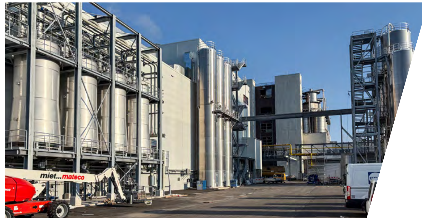
Betriebsgebäude und Silos für die Produktion von Polyesterfolien von Mitsubishi Polyester Film im Industriepark Wiesbaden.
