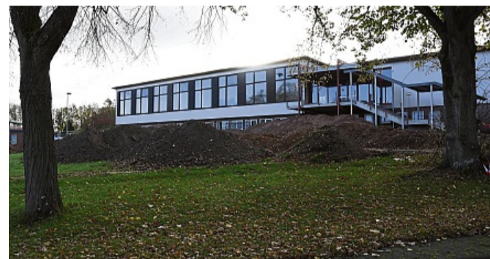
Vor dem Abriss: die alte Kantine der Bundeswehr-Soldaten in der Alheimer-Kaserne. FOTO: BUNDESPOLIZEI ROTENBURG
