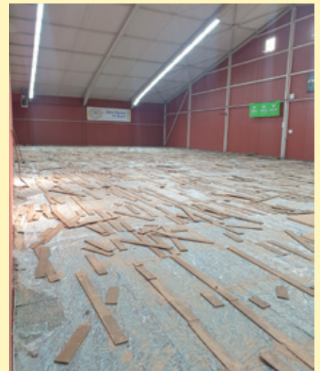
Die Unterkonstruktion des alten Bodens wird entfernt.
