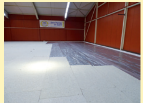
Die Unterkonstruktion des neuen Bodens wird gelegt.
