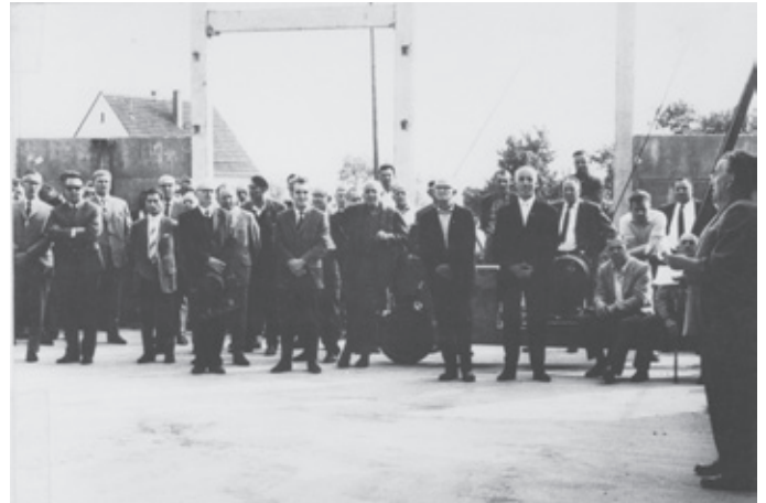
Aufnahme anlässlich des Baubeginns der Sport- und Kulturhalle 1964 der TG 1874 Langendiebach
